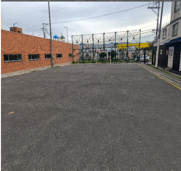
Fotografía 15 – Cerramiento NORTE Cancha MICROFUTBOL
