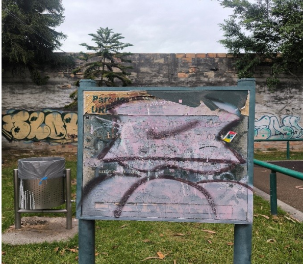
Fotografía 7 – Agrietamiento Cancha BALONCESTO
