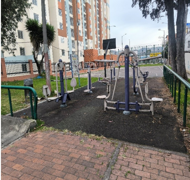
Fotografía 9 – PISO CAUCHO zona juegos en mal estado
