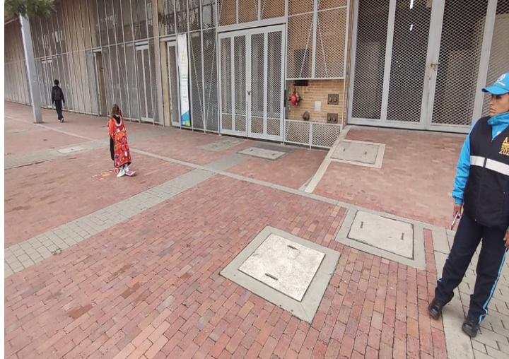
Imagen No.3: Tapas de inspección parque Fontanar del río marzo 2026
