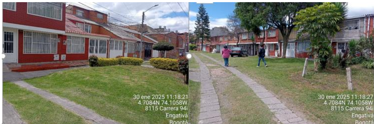
Fuente: Subdirección Técnica de Construcciones 10-442 – Urbanización Quiriguá, Engativá.
