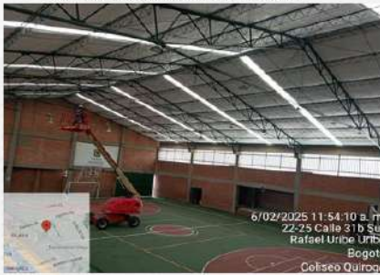
Mantenimiento coliseo Parque Quiroga
