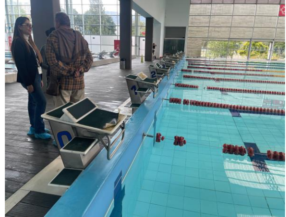
Imagen No.4: Partidor en avanzado estado de deterioro.
