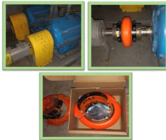
Imagen No. 1: Mantenimiento correctivo Motobomba No.2 Piscina de Clavados - Complejo acuático
