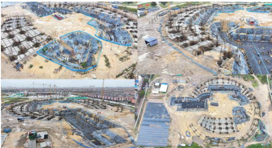
Fuente: Subdirección Técnica de Construcciones
