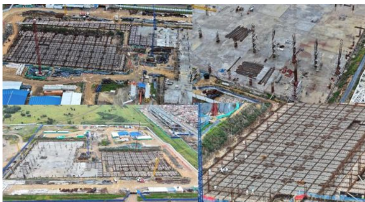
Fuente: Subdirección Técnica de Construcciones
