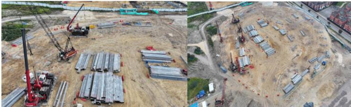
Fuente: Subdirección Técnica de Construcciones
