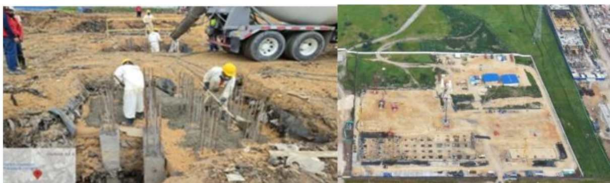
Fuente: Subdirección Técnica de Construcciones
