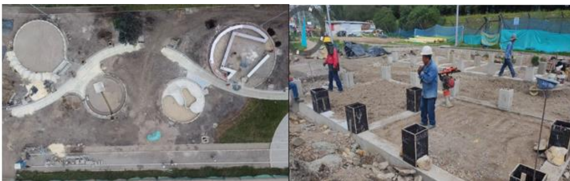
Fuente: Subdirección Técnica de Construcciones
